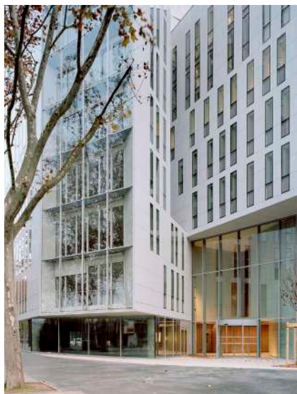
Edifício de Escritórios Parkview FRANÇA 2019
