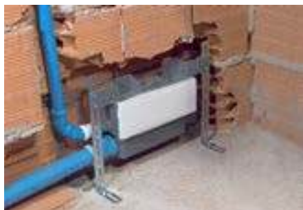
Aplicação em parede de alvenaria
